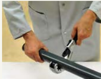
2. Retvinklet skæring af rør med rørskærer.
