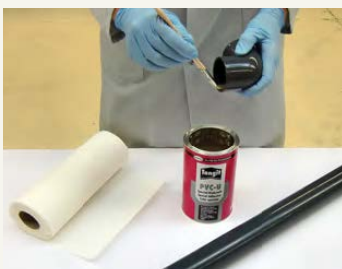
7. Påfør klæber i længderetning i muffen og på spidsenden og pres delene sammen uden at vride.
