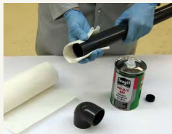
6. Rengøring af rør og muffe med Tangit rensesvæske.
